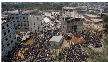
Effondrement d'un immeuble au Bangladesh
